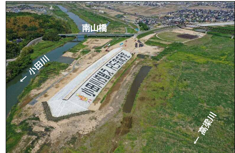
③高梁川から見た上流締切堤防
