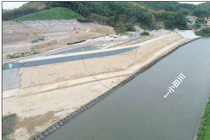
①小田川下流から見た県道迂回路、上流締切堤防
