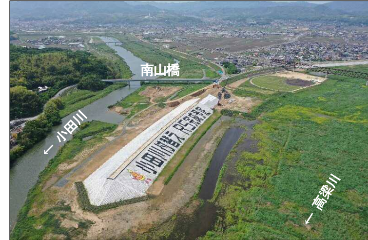
③高梁川から見た上流締切堤防
