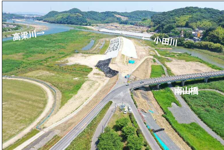
②小田川上流から見た上流締切堤防
