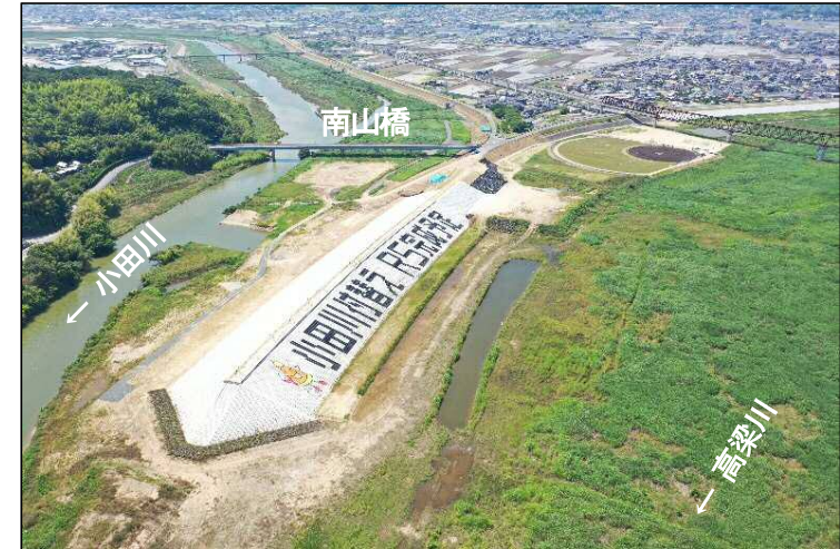
③高梁川から見た上流締切堤防
