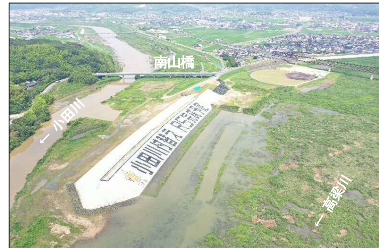
③高梁川から見た上流締切堤防
