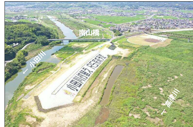
③高梁川から見た上流締切堤防
