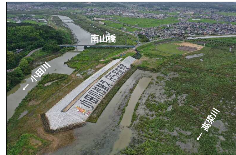
③高梁川から見た上流締切堤防
