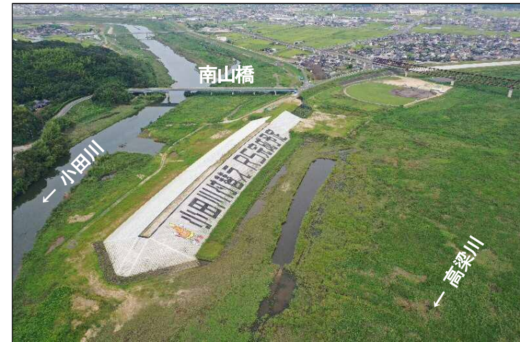
③高梁川から見た上流締切堤防
