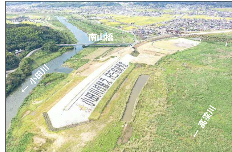
③高梁川から見た上流締切堤防
