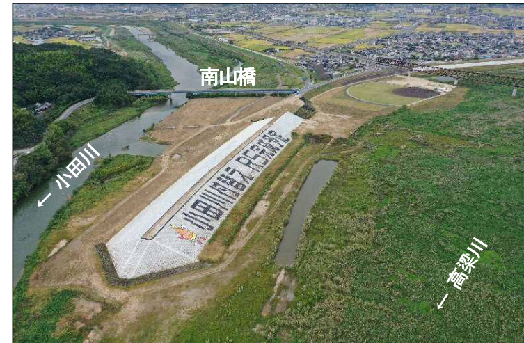
③高梁川から見た上流締切堤防
