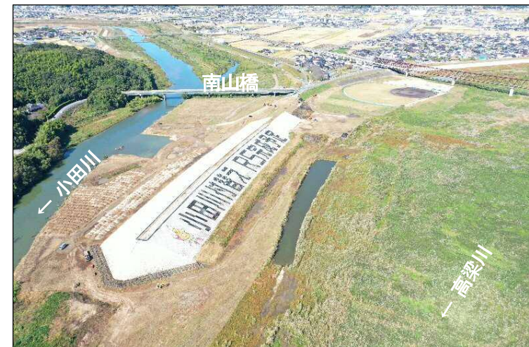
②高梁川から見た上流締切堤防
