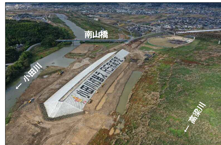
②締切堤防区間(下流より望む)
