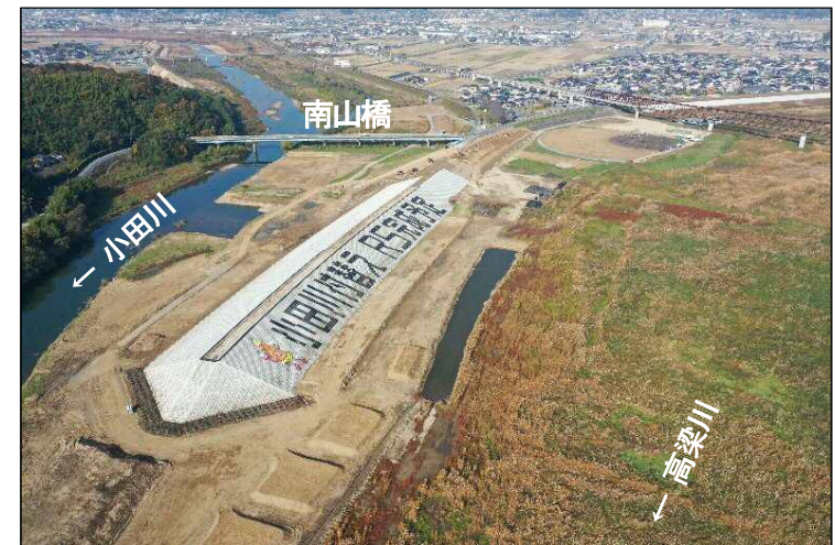
②締切堤防区間(下流より望む)
