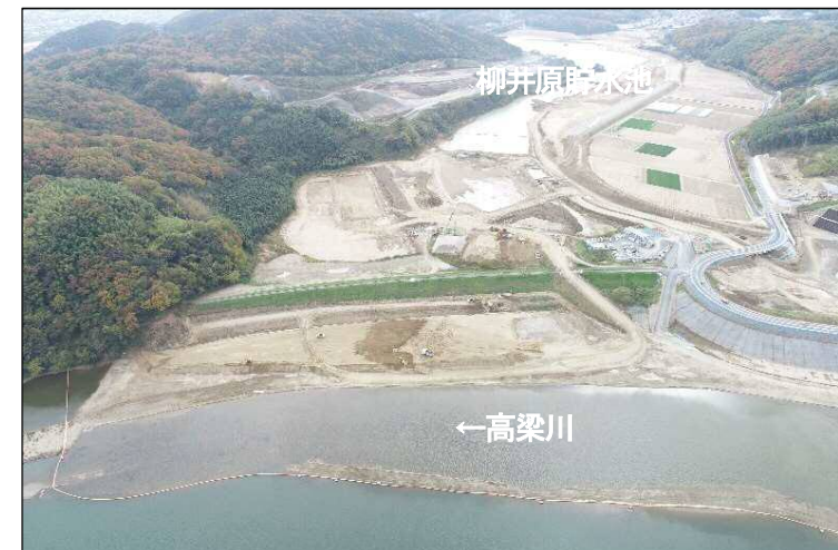
②締切堤防区間(高梁川より望む)
