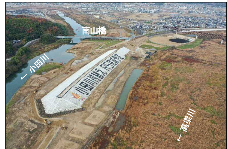
②締切堤防区間(下流より望む)
