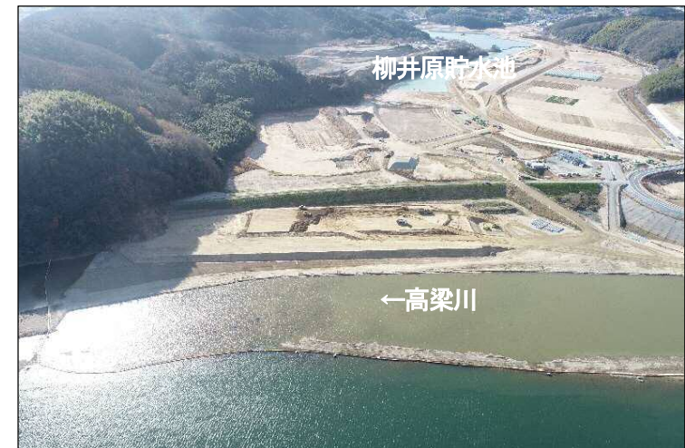
②締切堤防区間(高梁川より望む)
