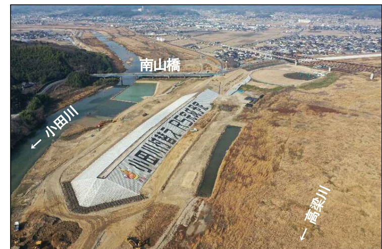
②締切堤防区間(下流より望む)
