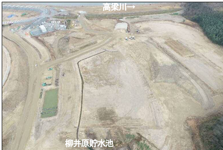
①河道掘削区間(上流より望む)
