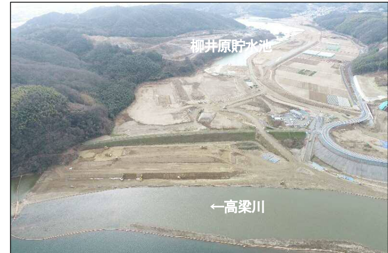
②締切堤防区間(高梁川より望む)
