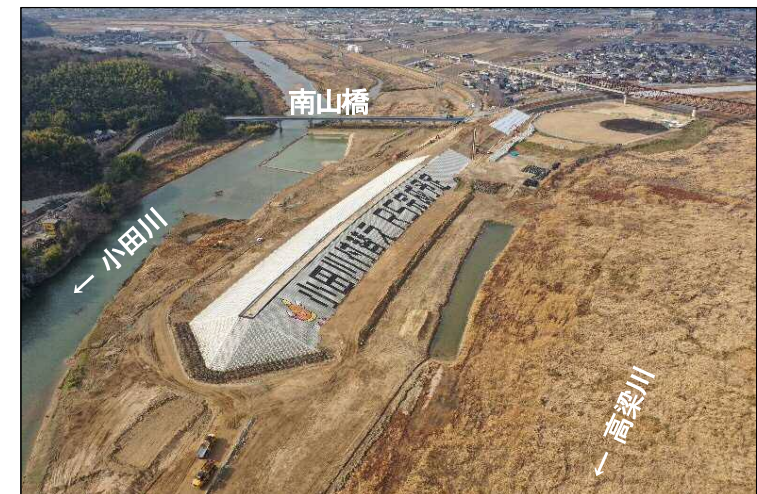
②締切堤防区間(下流より望む)
