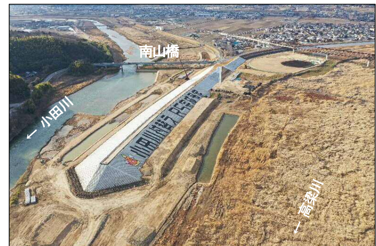
②締切堤防区間(下流より望む)
