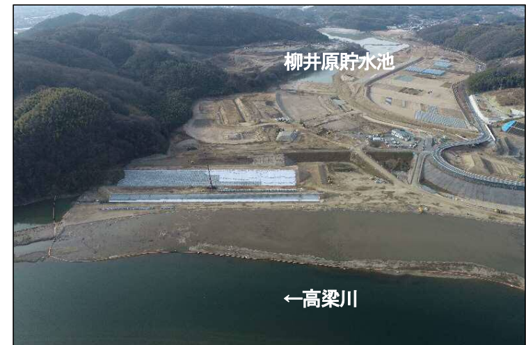
②締切堤防区間(高梁川より望む)
