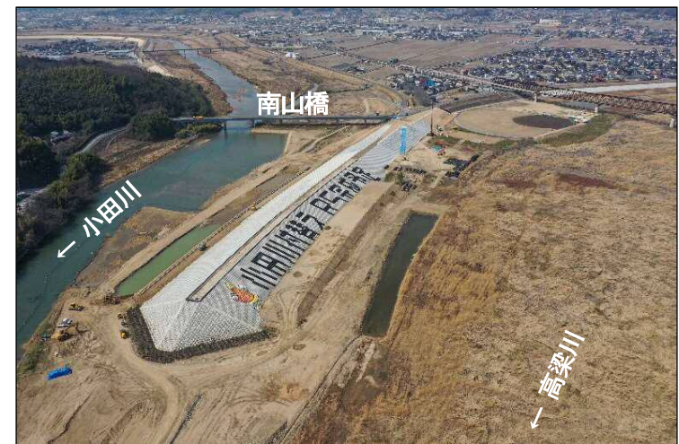
②締切堤防区間(下流より望む)
