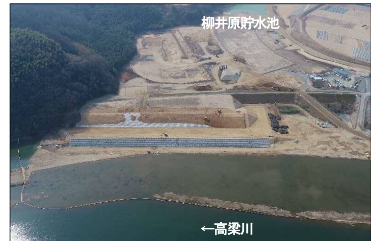
②締切堤防区間(高梁川より望む)
