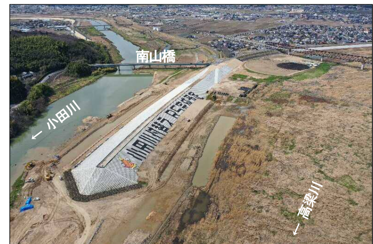
②締切堤防区間(下流より望む)
