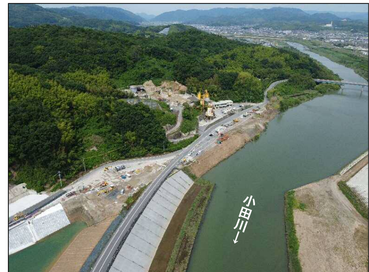
③護岸施工(下流より望む)
