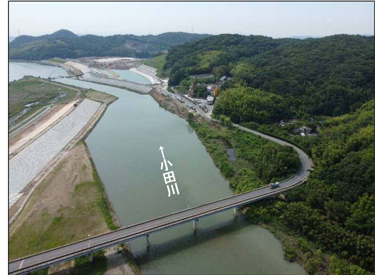
①護岸施工(上流より望む)
