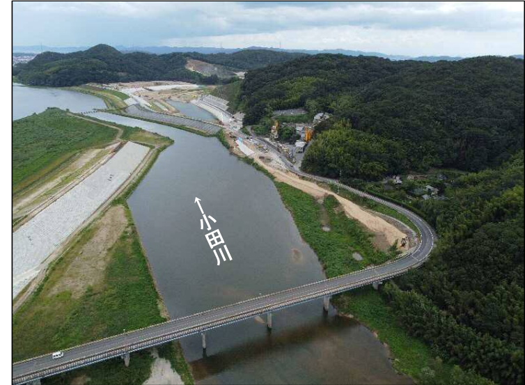
①護岸施工(上流より望む)
