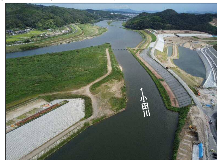
③護岸施工(上流より望む)
