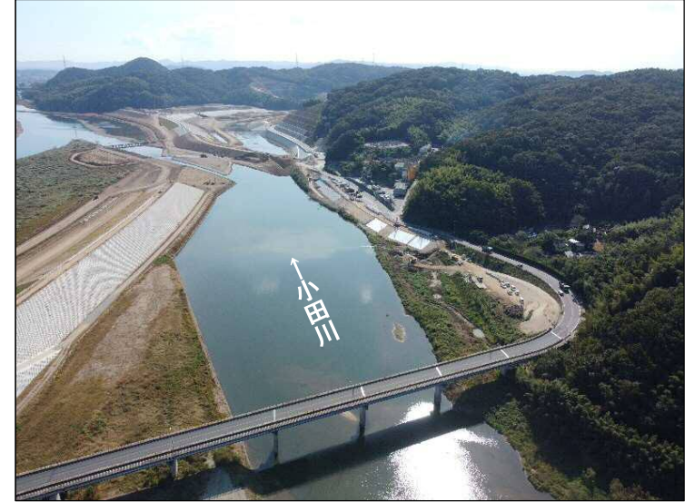
①護岸施工(上流より望む)
