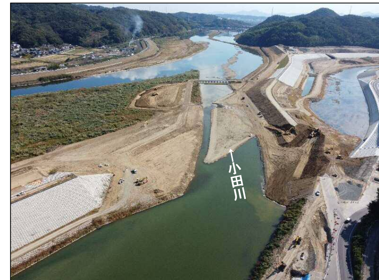
③護岸施工(上流より望む)
