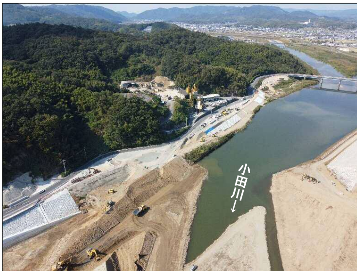
②護岸施工(下流より望む)
