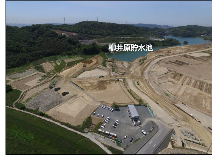
④現合流点から見た貯水池
