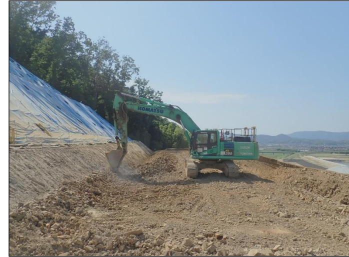
現地作業状況
