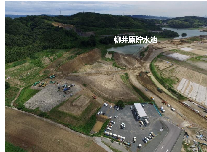
④現合流点から見た貯水池
