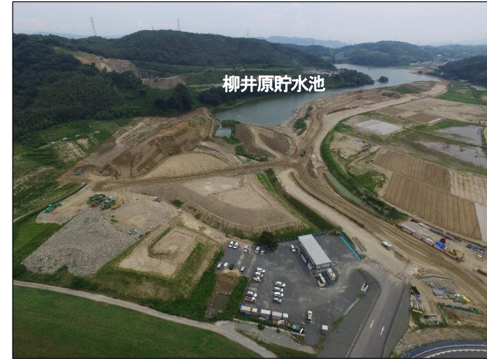
④現合流点から見た貯水池
