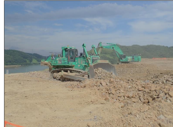
現地作業状況
