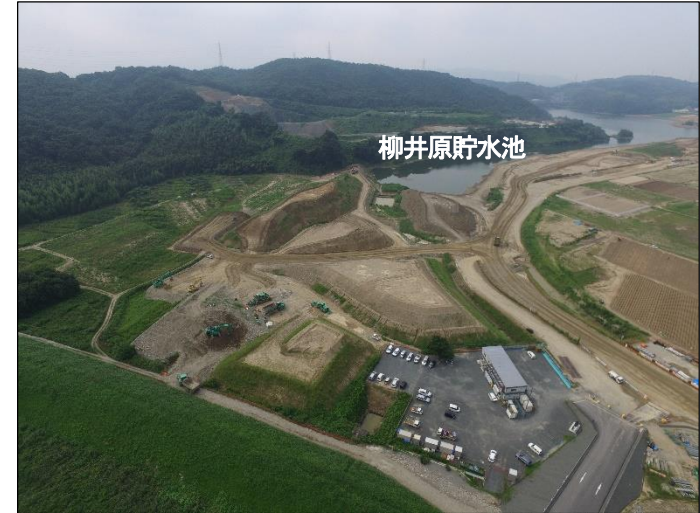
④現合流点から見た貯水池
