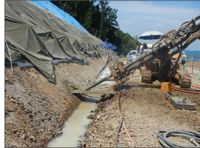
現地作業状況
