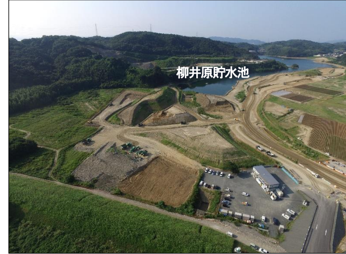
④現合流点から見た貯水池
