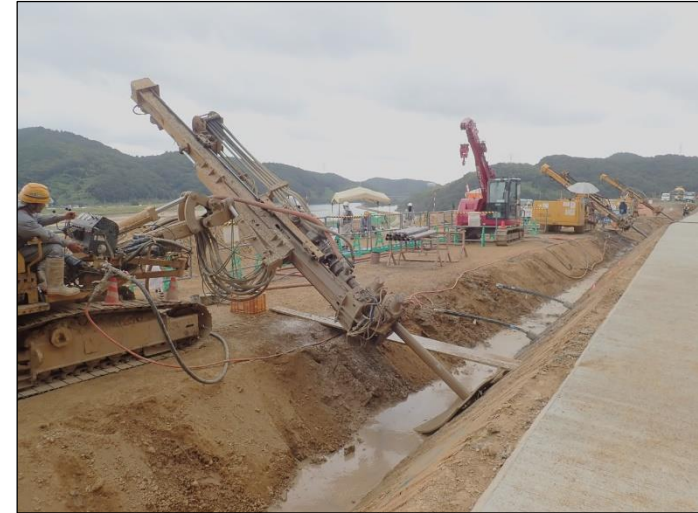
現地作業状況
