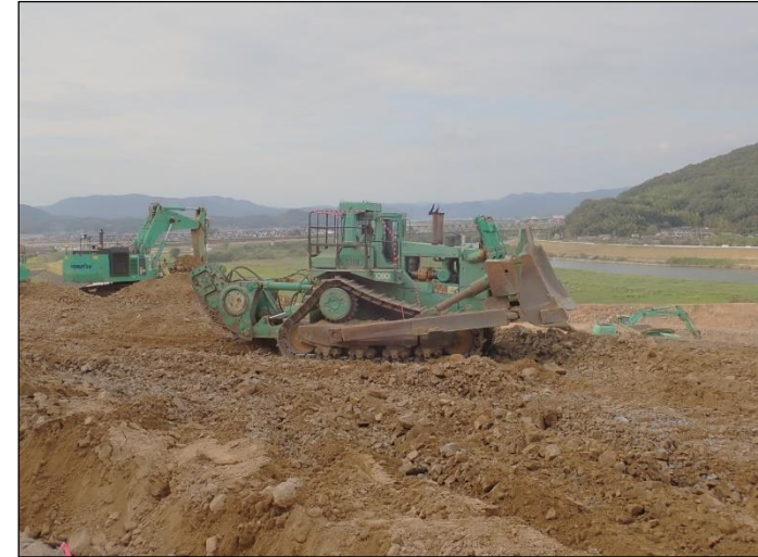
現地作業状況
