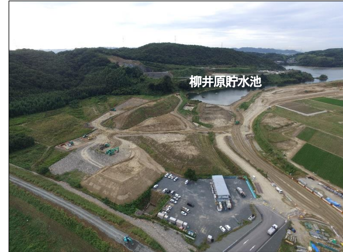
④現合流点から見た貯水池
