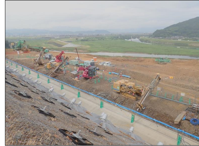
現地作業状況
