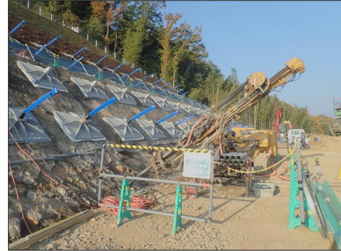
現地作業状況
