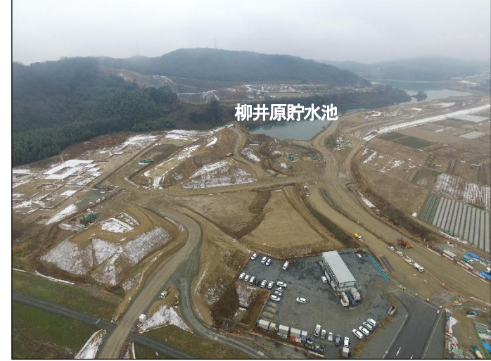
④現合流点から見た貯水池
