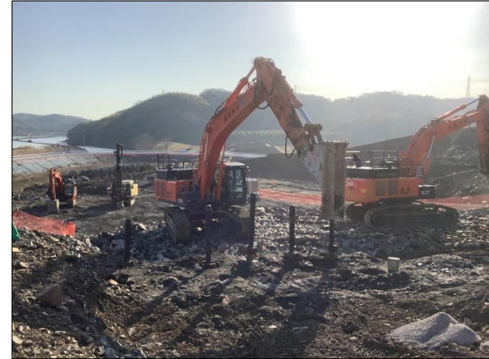
現地作業状況
