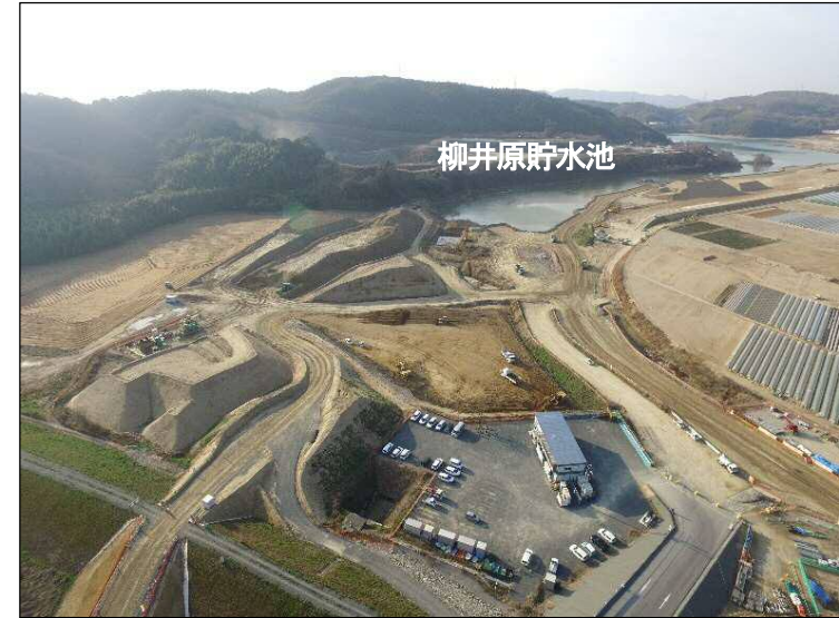
④現合流点から見た貯水池
