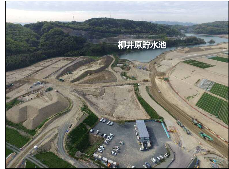
④現合流点から見た貯水池
