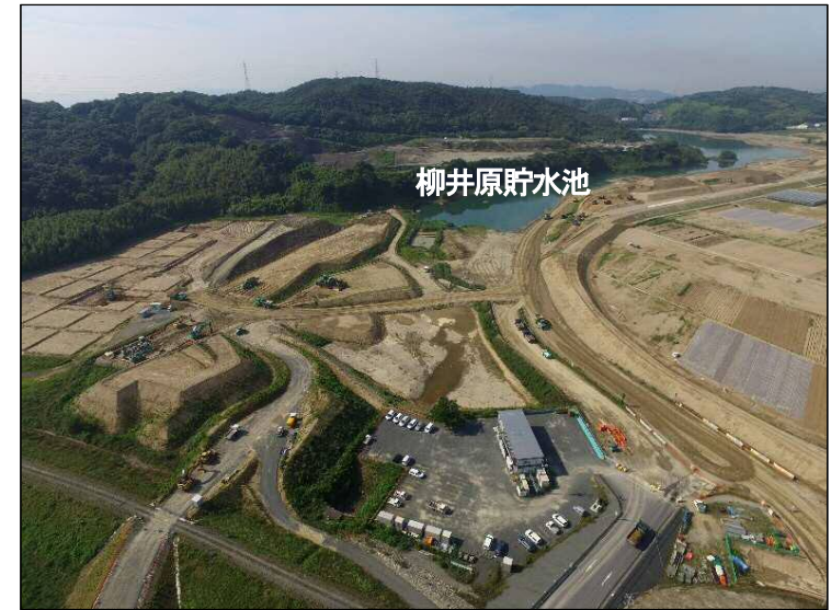
④現合流点から見た貯水池
