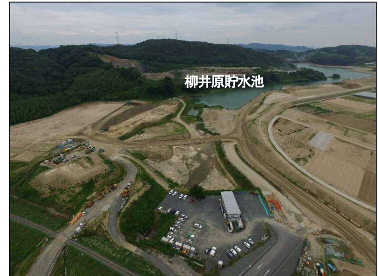
④現合流点から見た貯水池
