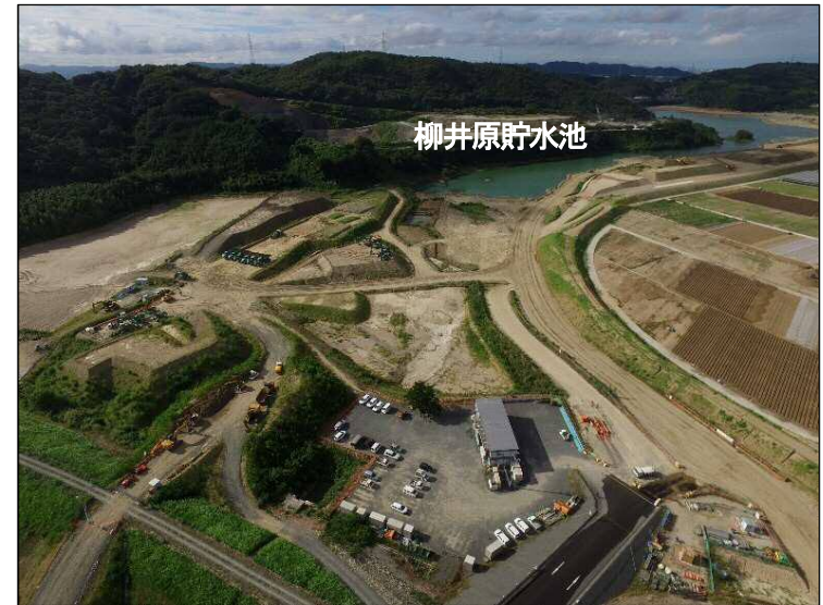
④現合流点から見た貯水池
