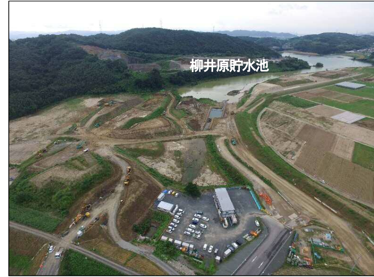
④現合流点から見た貯水池
