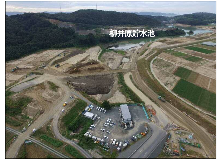
④現合流点から見た貯水池
