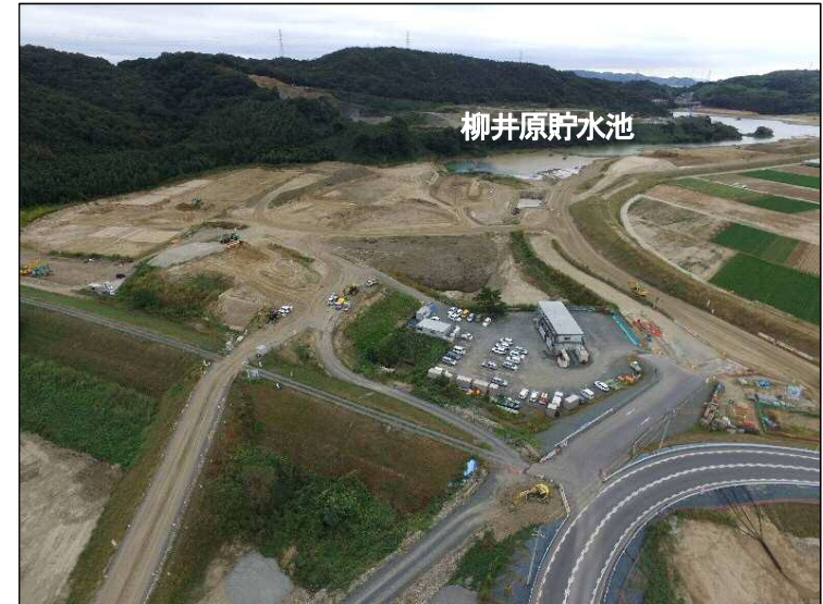
④現合流点から見た貯水池
