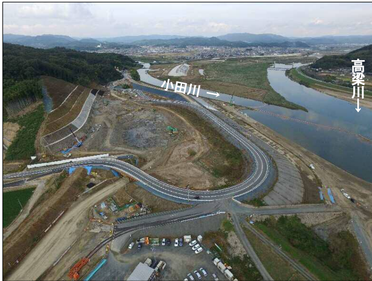
③南山掘削区間(上流より望む)
