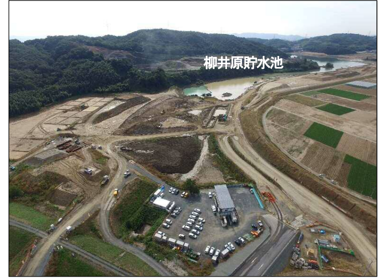
④南山掘削区間(現合流点より望む)
