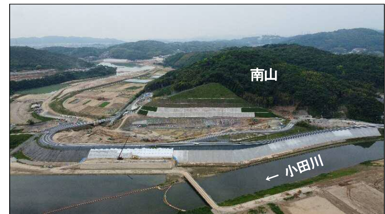
②南山掘削(高梁川より望む)
