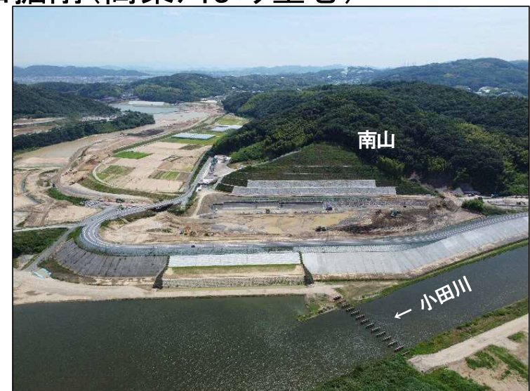
②南山掘削(高梁川より望む)
